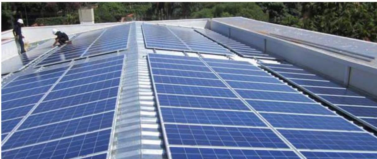
Figura 75. Exemplo de estrutura de fixação sobre telhas metálicas.
